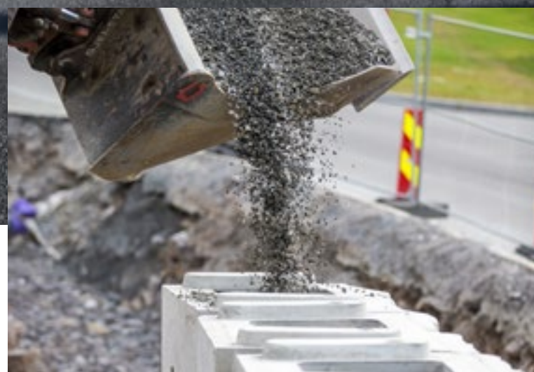
FYLL: Muren fylles med 8-16 etter hvert som rastene kommer på.
