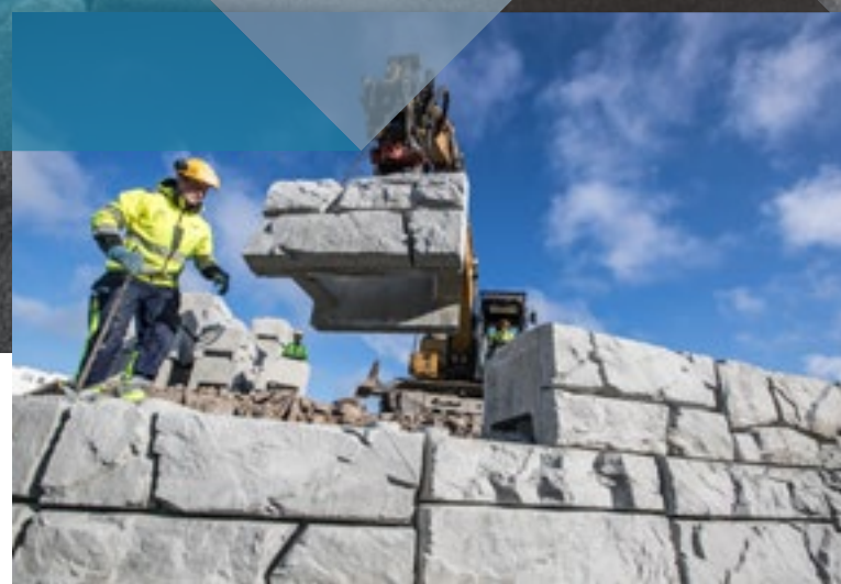
STABLER: Espen Marhaug guider blokken på plass. Kristian Larsen er klar til å huke på neste blokk, mens Einar Krekling kjører graveren. (Alle foto: Jørn Söderholm)
