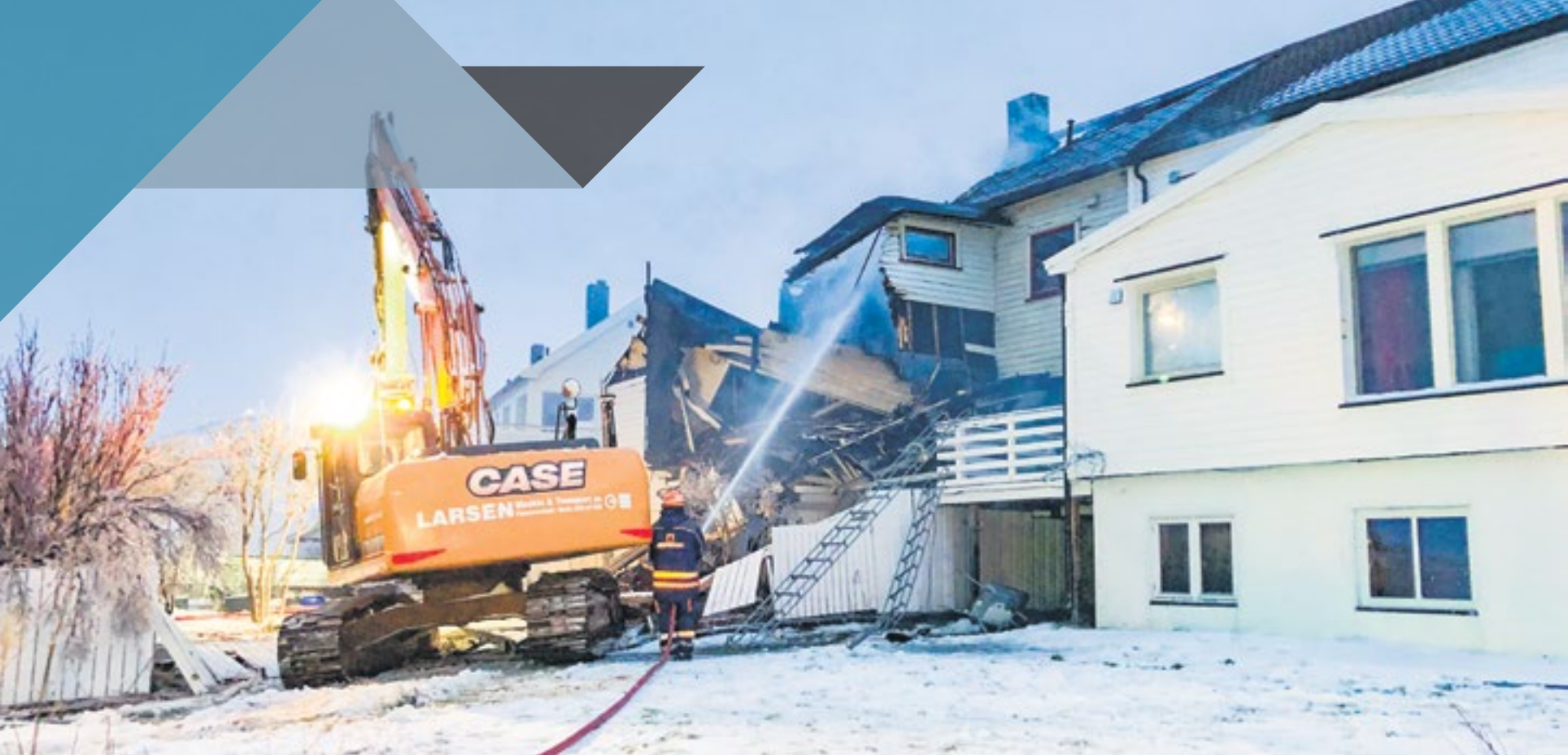
RIVER: Larsen Maskin & Transport AS fikk en hasteutkalling i romjulen. En brann i et bolighus truet med å spre seg utover i sentrum. Brannvesenet besluttet riving mens slokking ennå pågikk. (Foto: Larsen)
